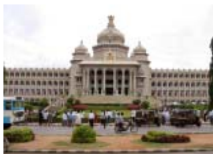
(卡拉塔克邦政府大楼)
